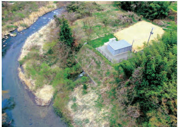
すりかみ浄水場小水力発電所
