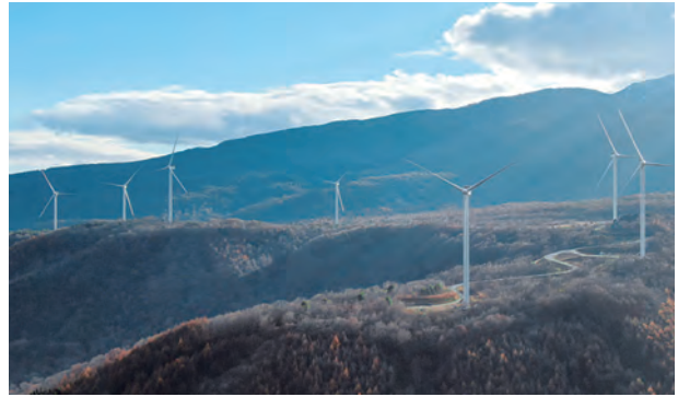
吾妻高原風力発電所
