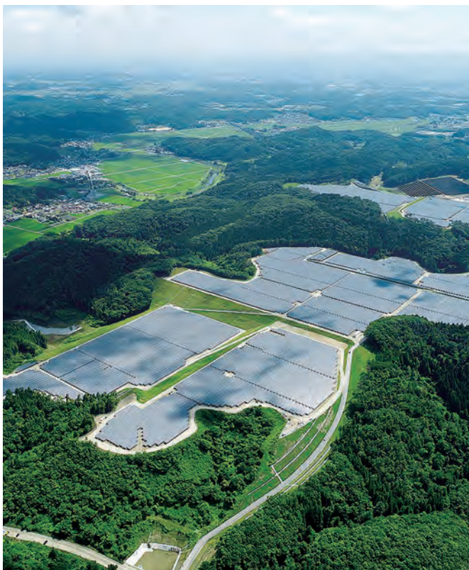
大規模太陽光発電所「白河ソーラーパーク」
