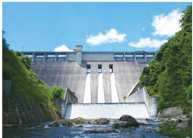
木戸ダム管理用水力発電所
